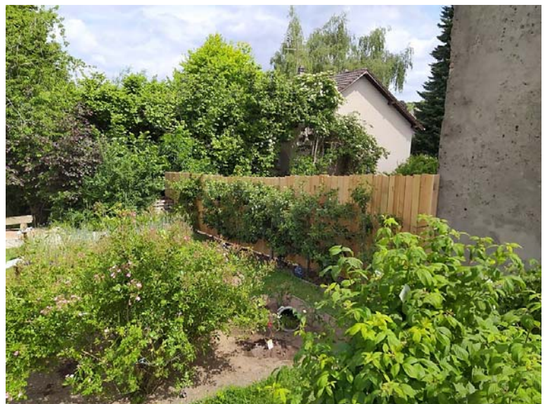
En raison de la détérioration précoce de la précédente palissade en bois tressé, celle-ci a été remplacée, par des lattes en bois fixées sur une infrastructure de tasseaux. Marcel, Jeannot, Patrick, ...
