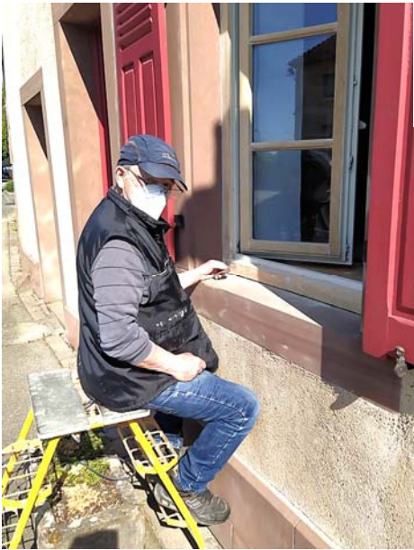
Décapage et peinture des fenêtres avant de la maison. Bernard
