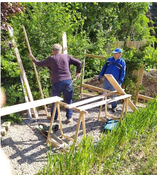
En raison de la détérioration précoce de la précédente palissade en bois tressé, celle-ci a été remplacée, par des lattes en bois fixées sur une infrastructure de tasseaux. Marcel, Jeannot, Patrick, ...
