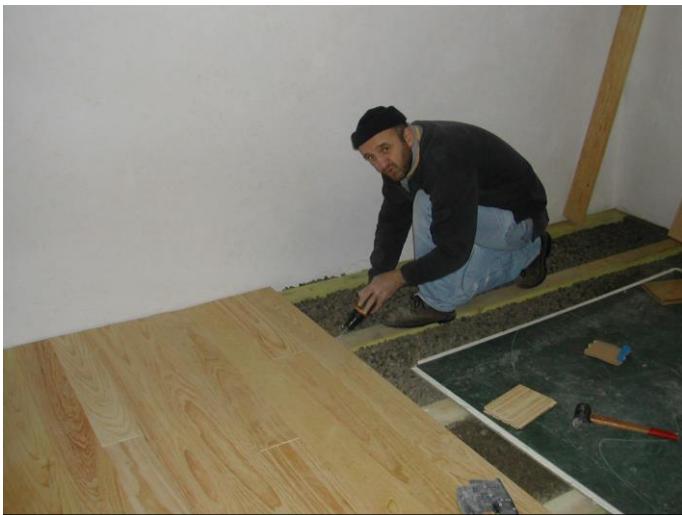
Pose du parquet
