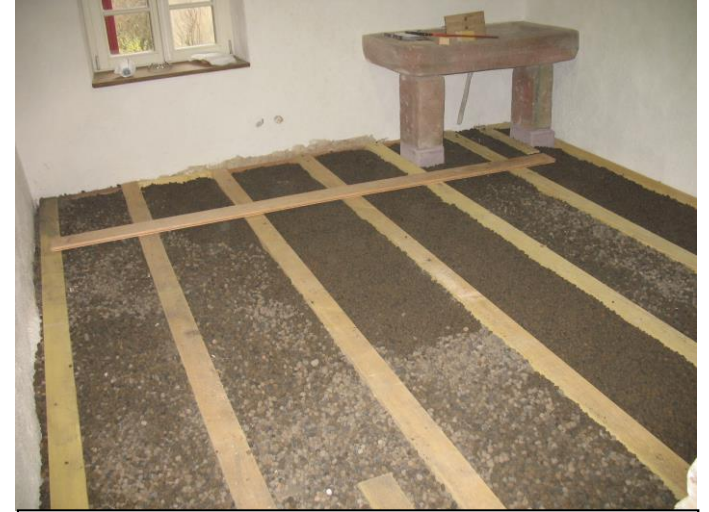
Remplissage du plancher par un produit isolant de l'humidité
