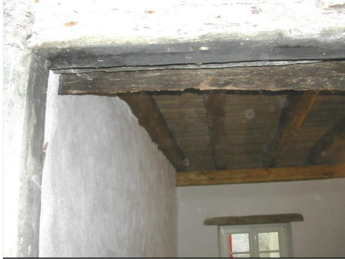
Crépi définitif des murs et nouveau plafond
