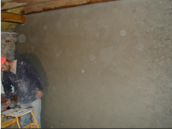
Pose sous-couche avant crépissage définitif des murs
