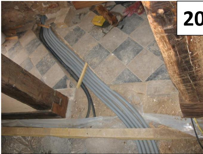
**Insertion des gaines dans les murs et sous le plancher en prévision des futurs besoins en électricité**
