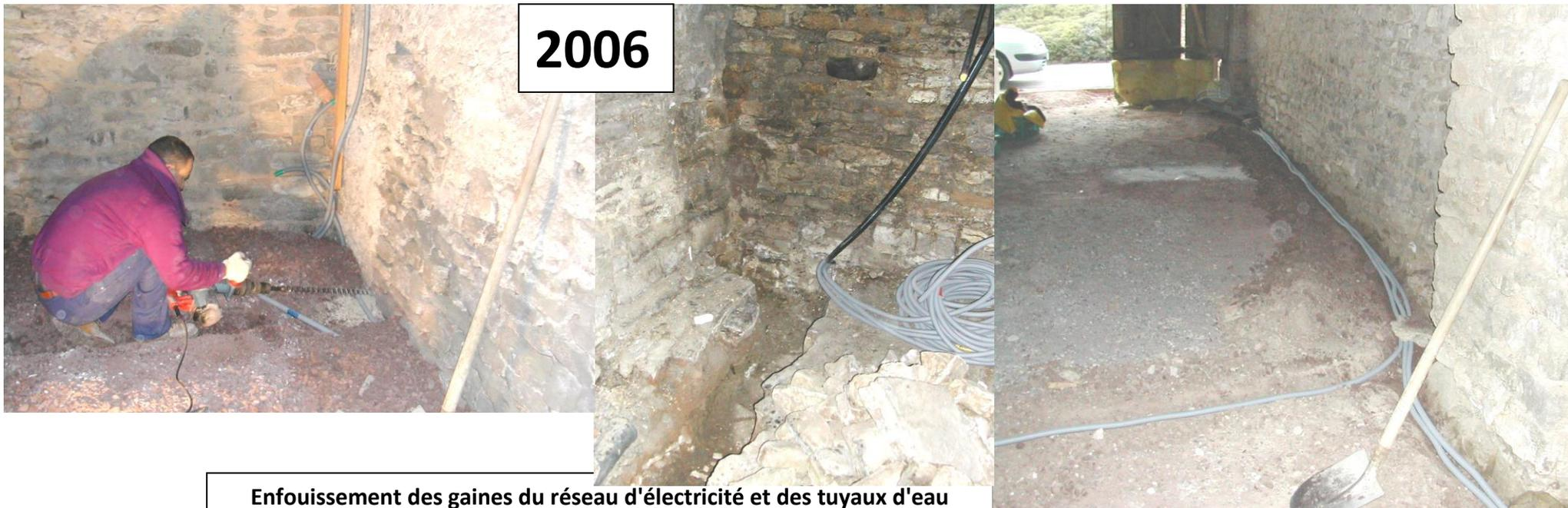
**Enfouissement des gaines du réseau d'électricité et des tuyaux d'eau avant que l'entreprise M&O coule la dalle en béton désactivé de la grange**
