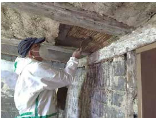
Les travaux de réfection des murs, du plafond en torchis et de l'isolation du mur côté grange avancent au fur et à mesure de la disponibilité des bénévoles.
