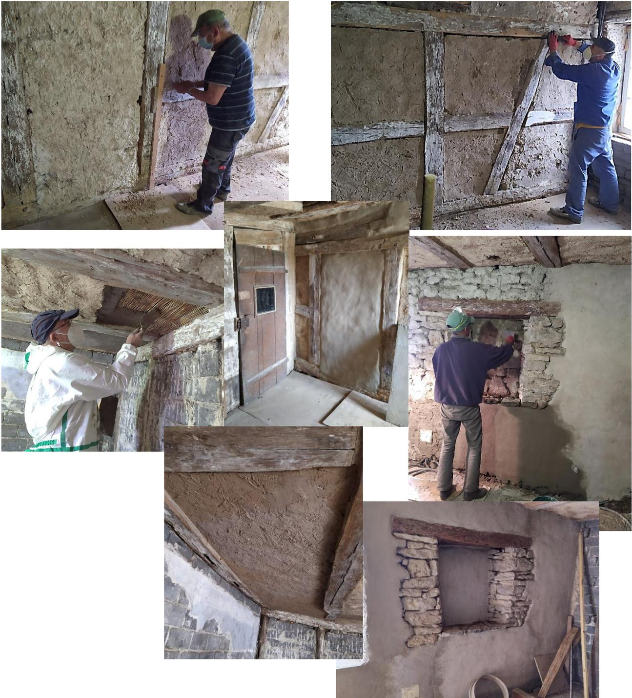
Les travaux de réfection des murs et du plafond en torchis avancent au fur et à mesure de la disponibilité des bénévoles. Ces travaux pourraient être terminés cette année et le remplacement du plancher s'effectuera probablement à partir de la reprise des activités en 2021.
