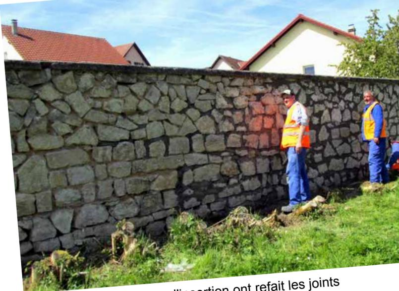
Les ouvriers du chantier d'insertion ont refait les joints du mur d'enceinte du cimetière.
