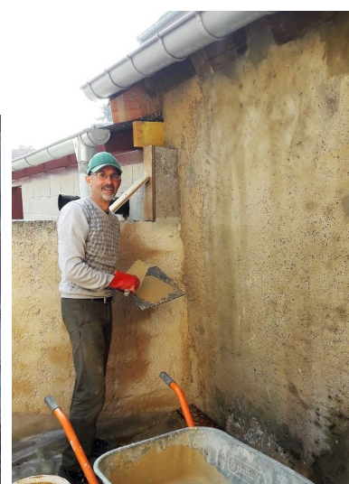
Rénovation du mur extérieur côté cuisine
