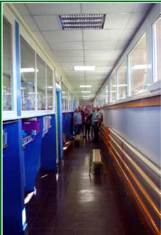
Pour finaliser le remplacement des anciens luminaires à l'école maternelle, un plafond suspendu, composé de 6 lampes LED, a été mis en place dans le couloir. Les avantages de ces lampes : surface de lumière uniforme, 35 % d'économies d'énergie, durée de vie de 30000 heures. Le coût total du matériel s'élève à 638.50€ TTC, l'installation a été réalisée par les agents du service technique.
